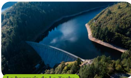
Le barrage de La Tâche
